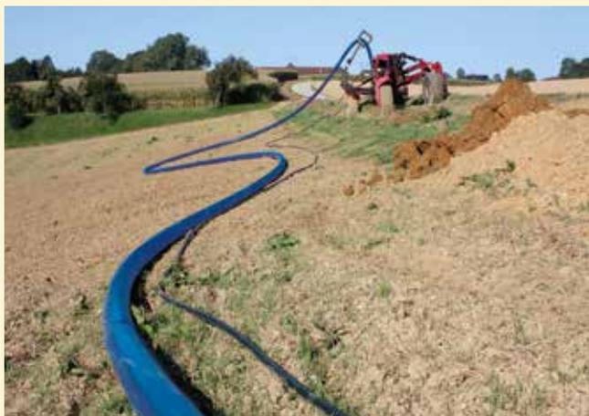
A camada sinalizadora colorida identifica a área de utilização, neste caso trata-se de uma conduta para água potável.
