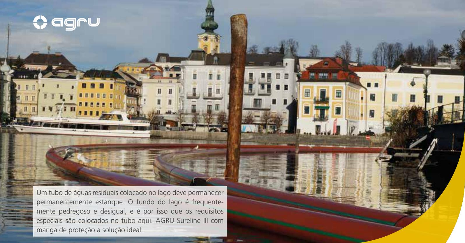
Um tubo de águas residuais colocado no lago deve permanecer permanentemente estanque. O fundo do lago é frequentemente pedregoso e desigual, e é por isso que os requisitos especiais são colocados no tubo aqui. AGRU Sureline III com manga de proteção a solução ideal.
